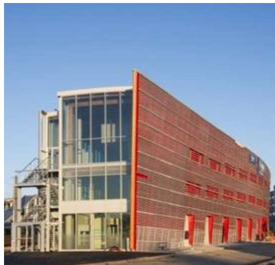
Pôle d'échanges à la gare TVG de Lorient, présenté au Forum Bois Construction au Centre Prouvé de Nancy le jeudi 6 avril à 15:40 par Olivier Boissonnet dans l'Atelier B2 Construction urbaine: Restructuration, surélévation, extension animée par Estelle Billiotte. Crédit photo : Arep
